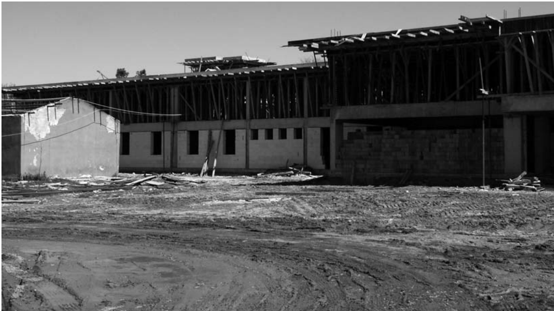
Erweiterungsbau des Haftlagers Edirne
